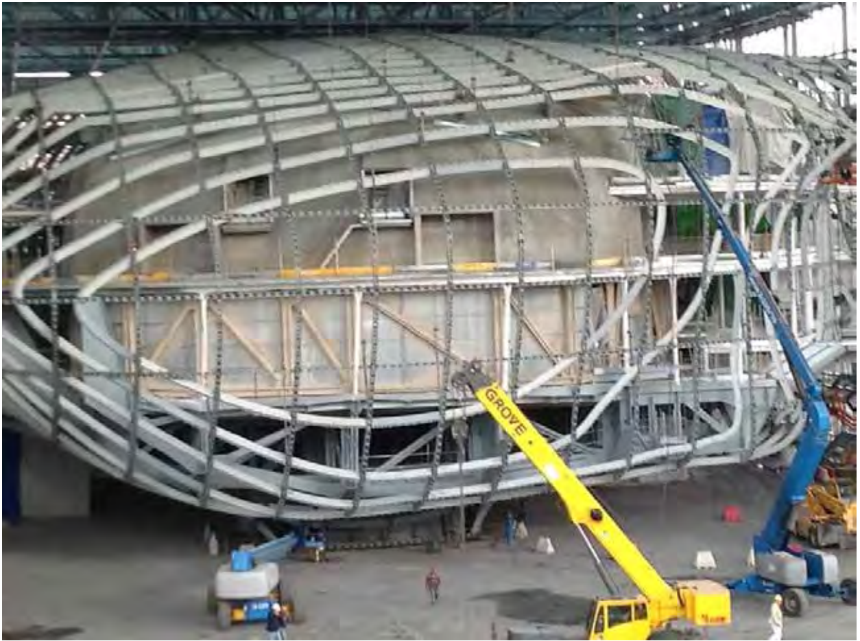
PLE al lavoro nel cantiere "NUVOLA" di Fuksas: Roma EUR, Nuovo Centro Congressi
